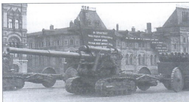
152-мм пушки Бр-2 внешне отличались от гаубицы Б-4 более длинным стволом
