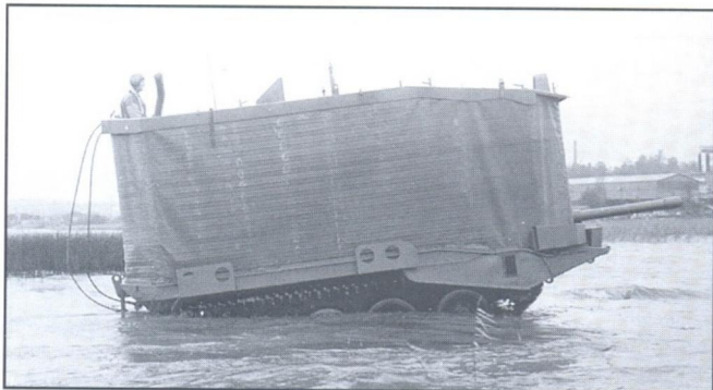
Подъемный экран для обеспечения плавучести танка
