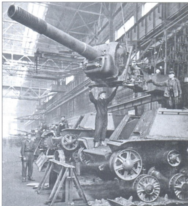
Монтаж ствола МЛ-20 в самоходную установку СУ-152 «Зверобой»
